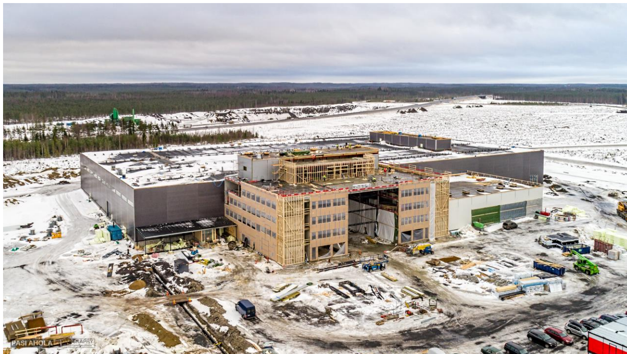
IL NUOVO STABILIMENTO DI FINN-POWER OY, IN COSTRUZIONE.
